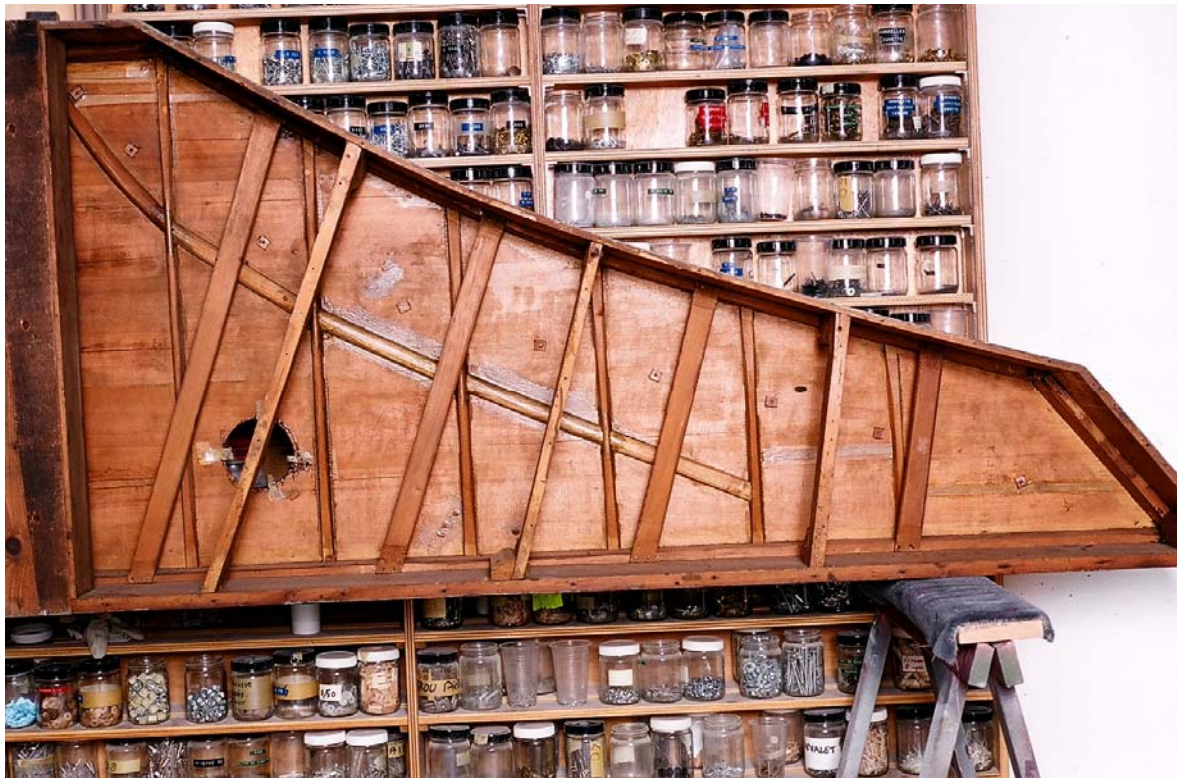
L'intérieur de la caisse, le fond déposé, photographié avant la restauration
